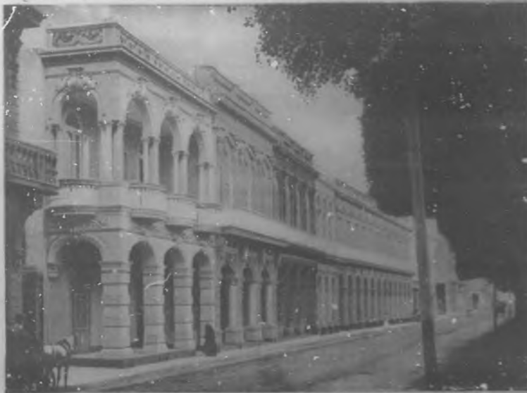
Un costado del Paseo de Martí. (Habana)
